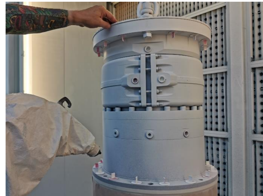
Lackieren des fertig sanierten Aggregats
