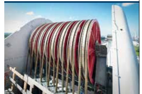
SEILSCHEIBEN DER BOTLEK BRIDGE
